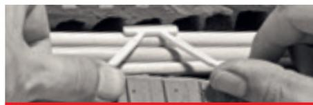
Viele Vorteile: werkzeuglose Kabelfixierung in senkrechten und waagrechten Mauerschlitzten, leichtes Überputzen, keine Beschädigungen der Leitungen.
