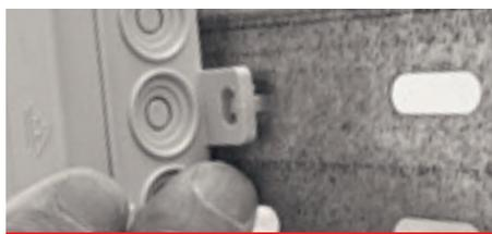
Mit dem SDC Schnabl Dosen-Clip gelingt eine kraft- und zeitsparende Montage von Abzweigdosen auf Kabeltrassen.
